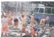
Flinker als angedacht: Bauarbeiter am Stadleroberplatz und im Seefeld.
